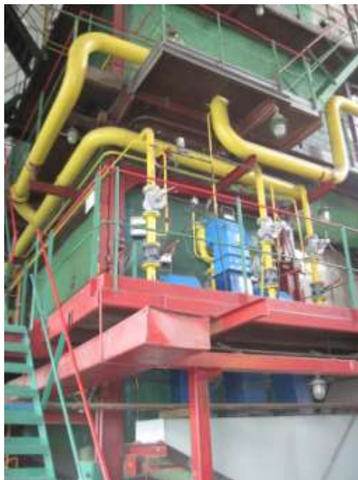
Рисунок 1.1.9. – Котел ПТВМ-30М з мікродифузійними пальниками після реконструкції
