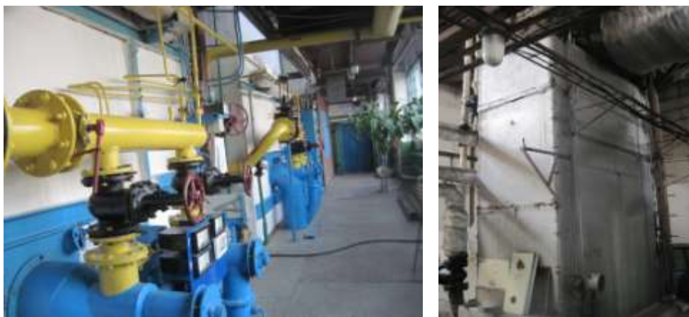
Рисунок 1.1.7.– Котли ДКВР з паливниками ГМГ і економайзери на котельні № 5
